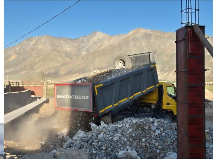
Après avoir surélevé les fondations de 90 cm au-dessus du niveau du sol, nous avons commencé à les remplir de gravier de tailles variées. Le remplissage a été effectué avec un nivellement soigneux à la pelle, garantissant une surface régulière.
