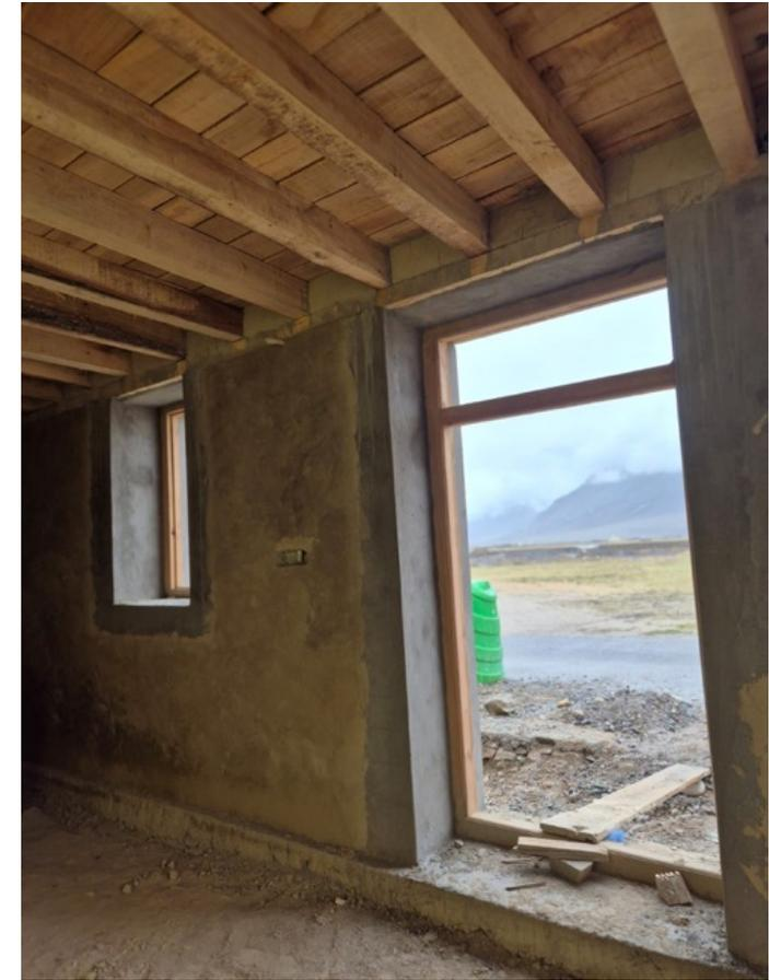
Le plâtrage intérieur a été terminé dans les pièces latérales, y compris les vestiaires des filles et des garçons avec leur réserve, ainsi que dans la cafétéria et la cuisine. Réalisé en enduit de terre, ce plâtre traditionnel est reconnu pour sa capacité à absorber l'humidité et à conserver la chaleur plus longtemps que le ciment.
