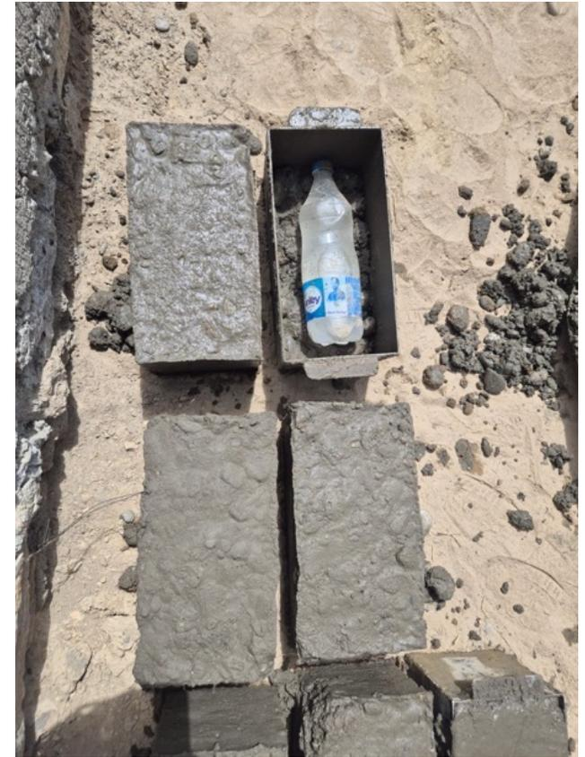
Les ouvriers préparent soigneusement les briques thermiques en remplissant les bouteilles plastiques de sel puis d'eau pour renforcer leur inertie thermique. Ces bouteilles ainsi préparées sont ensuite intégrées dans des blocs de béton, formant des briques composites.
