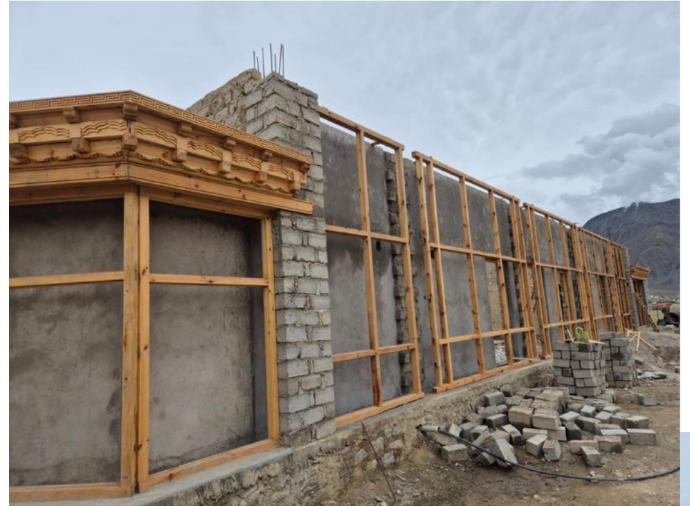
Malgré la situation météo exceptionnelle, la maçonnerie des quatre côtés du bâtiment est désormais achevée et le projet est passé à la phase de plâtrage, à la fois pour les façades extérieures et intérieures.
