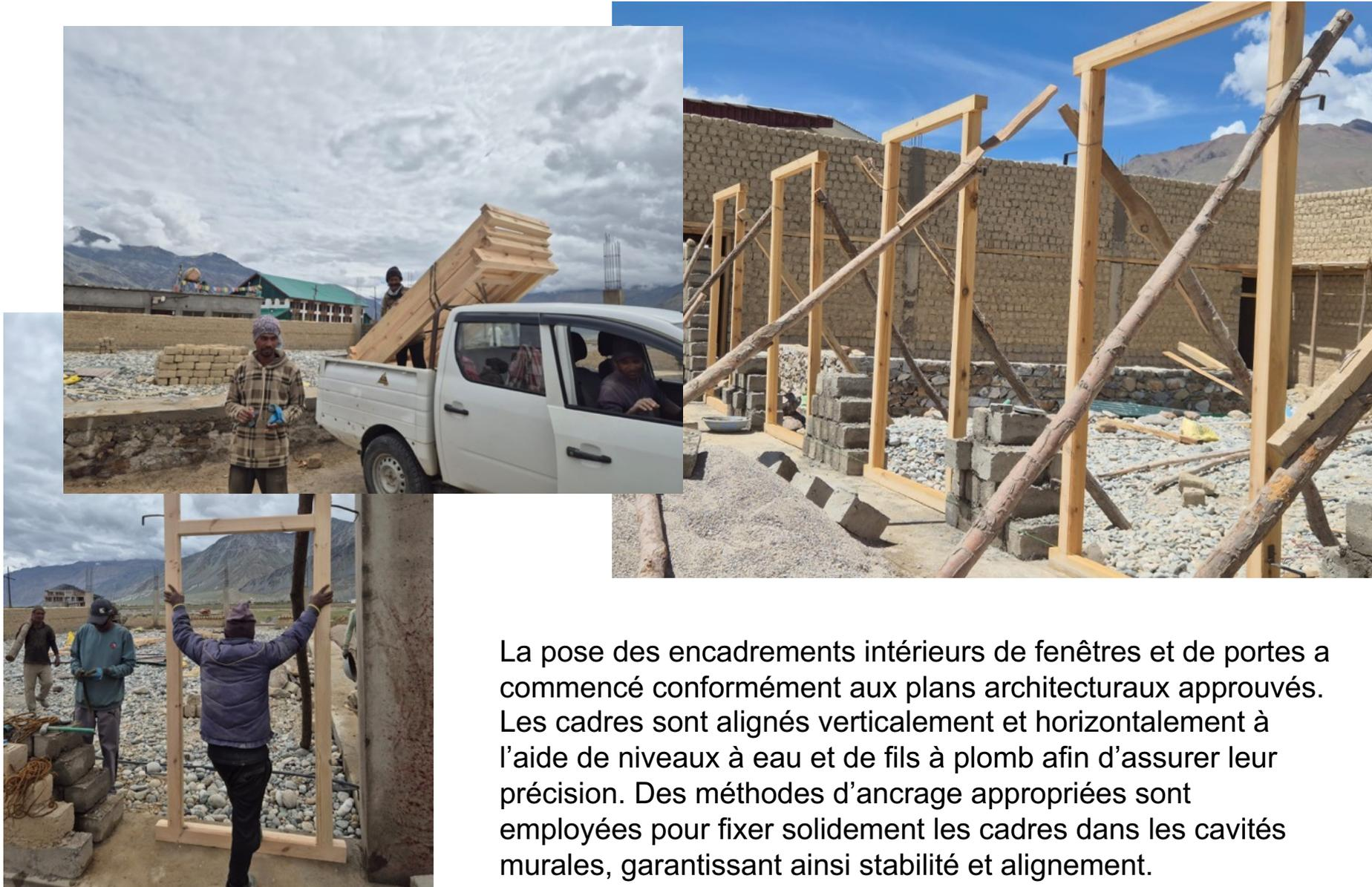
La pose des encadrements intérieurs de fenêtres et de portes a commencé conformément aux plans architecturaux approuvés. Les cadres sont alignés verticalement et horizontalement à l'aide de niveaux à eau et de fils à plomb afin d'assurer leur précision. Des méthodes d'ancrage appropriées sont employées pour fixer solidement les cadres dans les cavités murales, garantissant ainsi stabilité et alignement.
