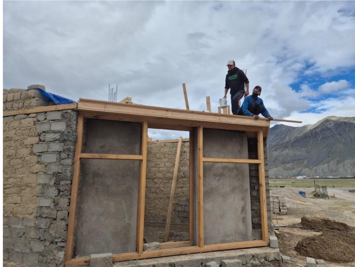
La pose des fenêtres extérieures a commencé dans les pièces latérales. Les techniciens qualifiés réalisent ce travail avec précision, en veillant au bon alignement. Un niveau à eau est utilisé pour vérifier l'horizontalité et la verticalité, garantissant l'exactitude et l'uniformité de l'ensemble des encadrements.
